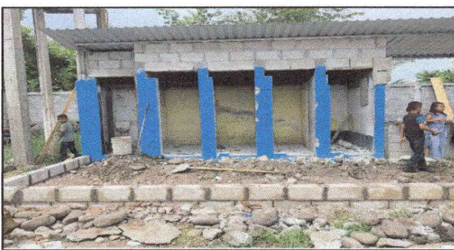
Foto 5: sustitución de puertas de metal, sustitución de piso de concreto por piso cerámico
