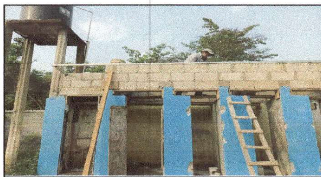
Foto 6: sustitución de sanitarios
