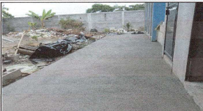
Foto 1: sustitución de puertas de metal en servicios sanitarios, cambio de lamina por lamina traquelada calibre 26
