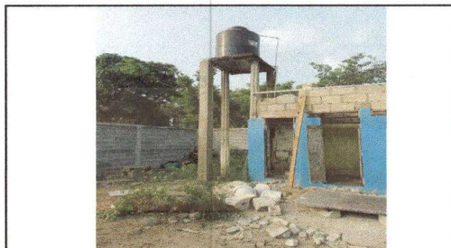
Foto 4: sustitución de mingitorios
