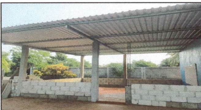
Foto 3: Estructura de portante de metal, lamina y mejoramiento de un aula
