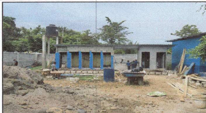
Foto 2: sustitución de puertas de metal en servicios sanitarios, cambio de lamina por lamina traquelada calibre 26
